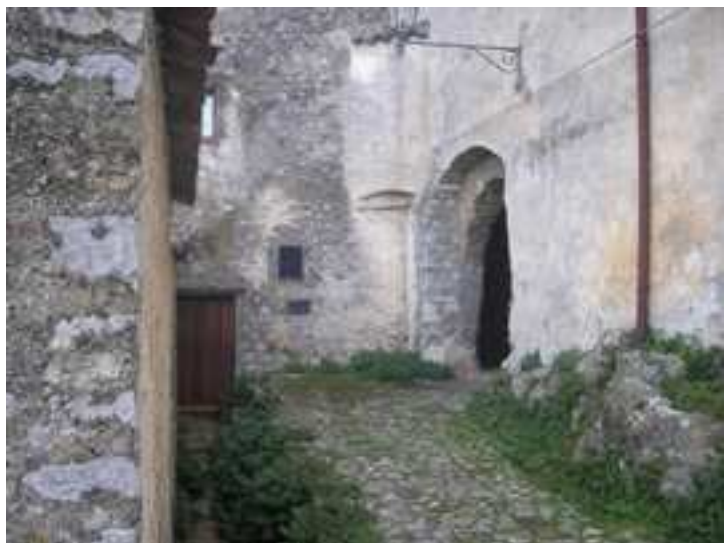
Interno della porta di accesso al Castello
